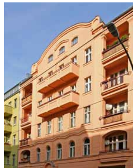
Denkmalgeschützte Fassade mit Wärmedämmung
