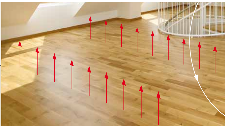
Das Raumklima wird durch Fußbodenheizung und kontrollierte Be- und Entlüftung gesteuert
